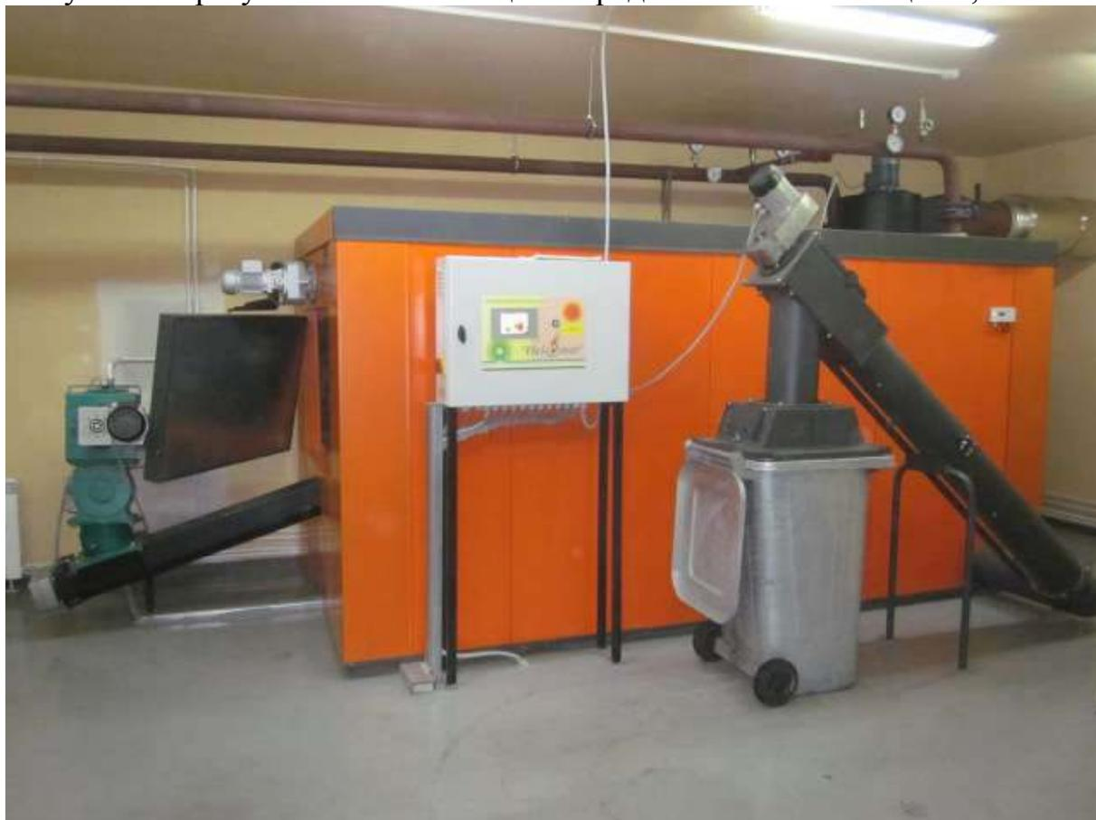
Рисунок 1 – Общий вид котельной на щепе.
