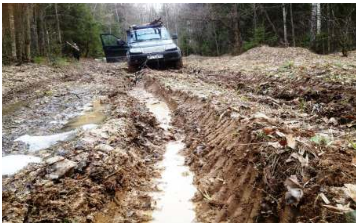
Рис. 3 Весенняя дорога после проезда трелевочных тракторов в Енисейском районе
