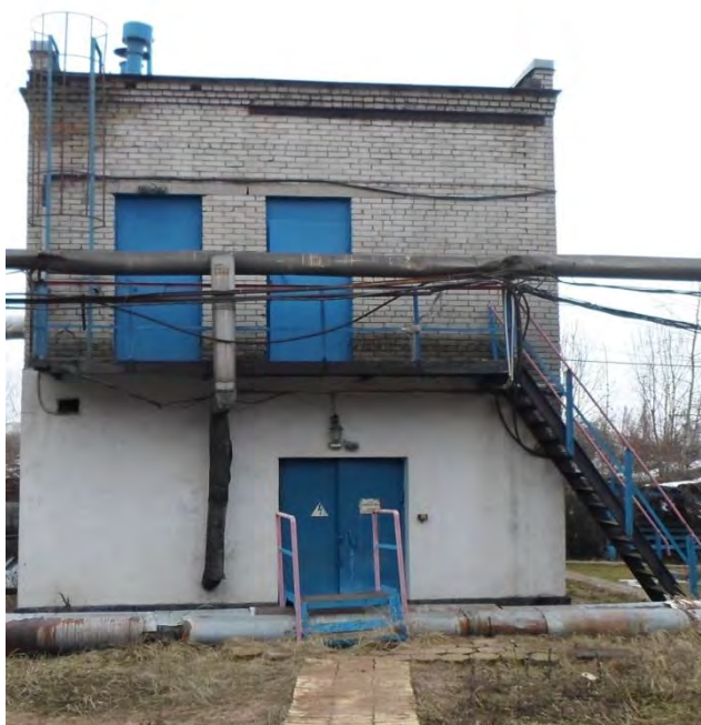
Рис. 3. Здание трансформаторной подстанции в г. Санкт-Петербург, станция метро Кировский Завод
