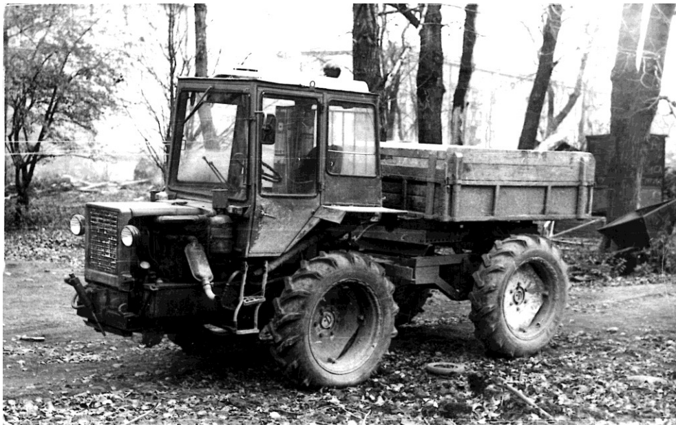
Рис. 5. Трактор Т-25АЛ с оборудованием для коммунального хозяйства
